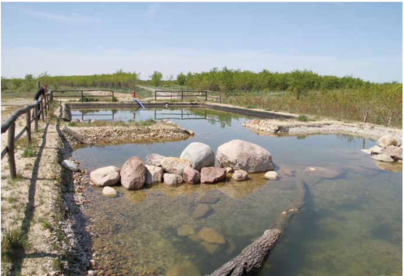
Amphibiengerechter Feuerlöschteich unmittelbar nach der Fertigstellung. Gestaltete Biotopzone im Vordergrund.
